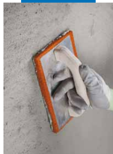
Frattazzatura di Planitop Rasa & Ripara
