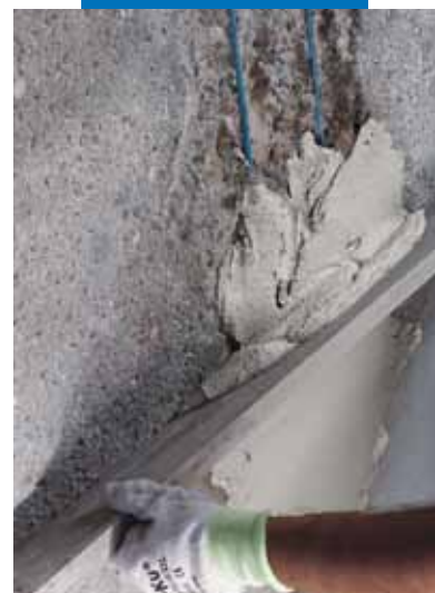
Staggiatura di Planitop Rasa & Ripara
